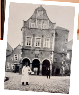
Das Meppener Rathaus mit bereits abgedecktem Turmdach um 1900 Quelle: Bildarchiv Heimatverein Meppen
